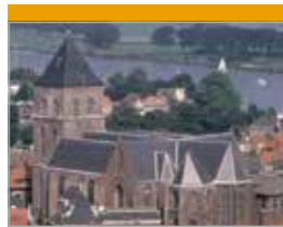
O.L. Vrouwe of Buitenkerk Buiten Nieuwstraat 101 Kampen
